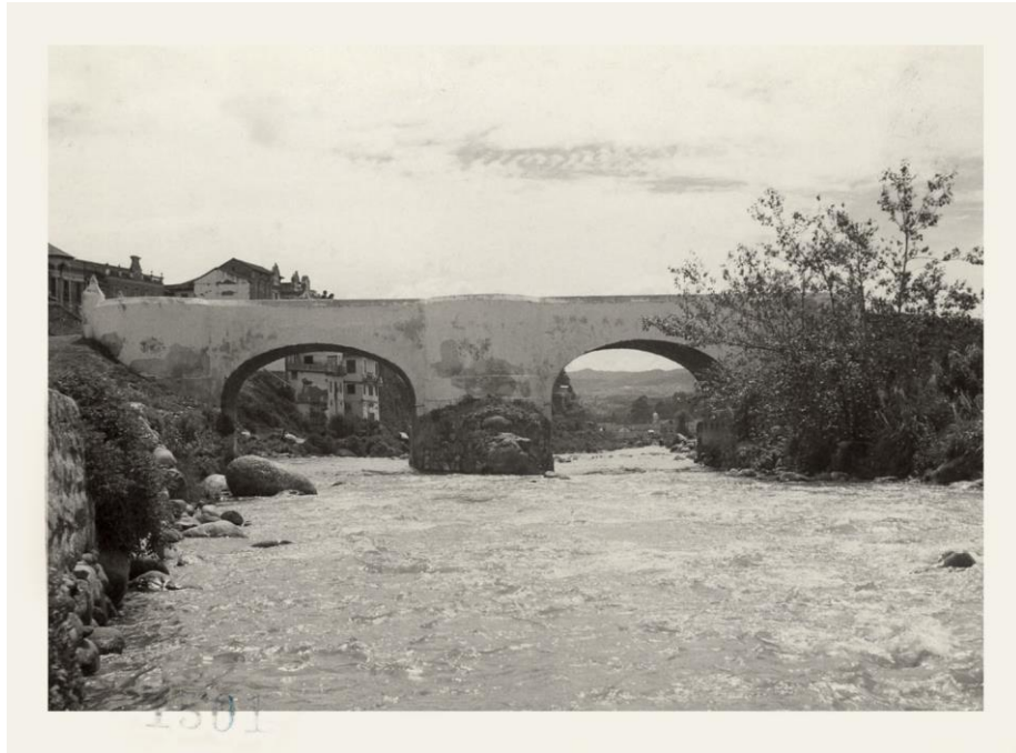
Ilustración 4: Fotografía del puente "El Vado"
