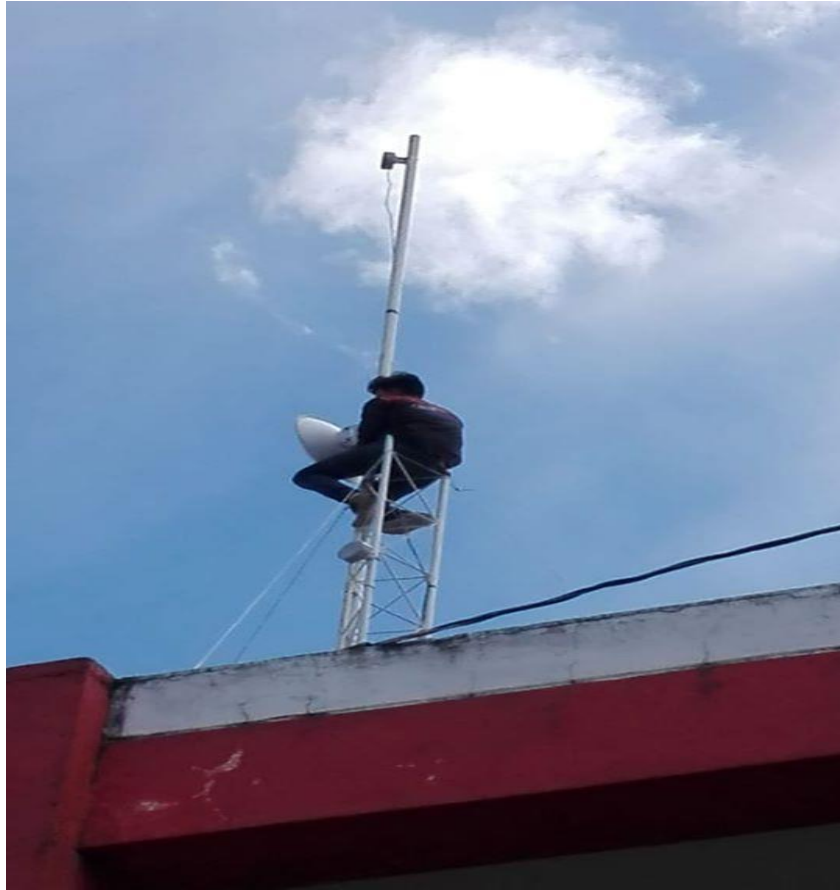
Figura 14 Infraestructura Otros Proveedores
