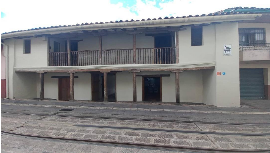
Fachada actual de la Casa de las Posadas. Fuente: Elaboración propia
