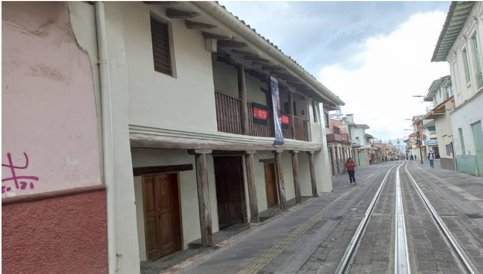
Vista lateral de la Casa de las Posadas Fuente: Elaboración propia
