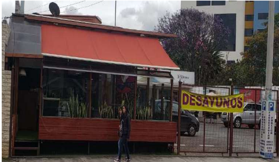
Ilustración 1: Infraestructura Moliendo Aroma Cafetería
