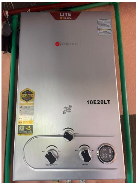
Ilustración 2 Calefón utilizado en el área de baño
