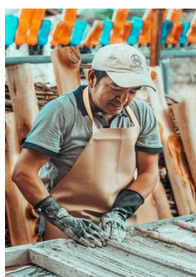
Ilustración 16 Realización de Estucos
